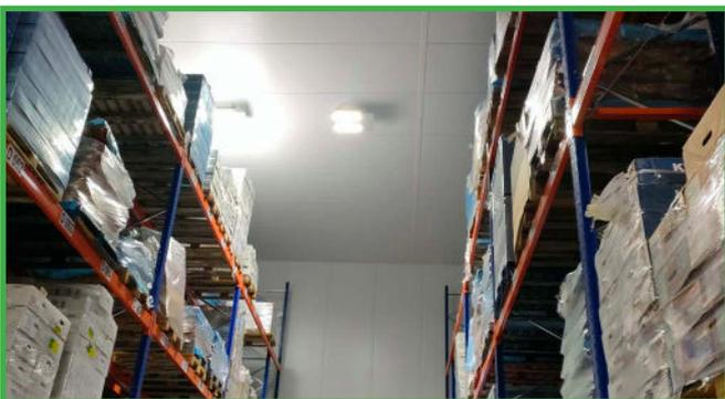
Courant 2023, nous avons effectué **un relamping** de 14 éclairages leds (à la place de 32 classiques) dans nos zones de cariste (principalement les congèles) avec des **éclairages leds intelligents équipés de détecteur de présence**. Cette nouvelle installation permet d'optimiser l'éclairage (en passant d'une consommation de 15 000 kWh à 1 400 kWh) et donc permettre d'éviter la surconsommation.
